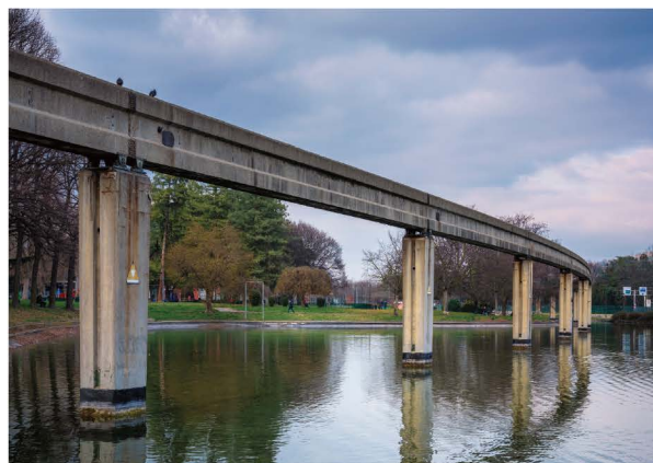
トリノ国際博覧会モノレールの軌道跡。現在も現地に残されている。
