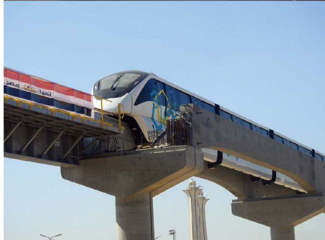
新行政首都の建設状況 軌道上の車両は新行政首都線、10 月 6 日線で採用された INNOVIA 300 MONORAIL（ALSTOM）
