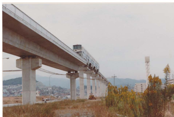
北九州モノレール 1000 形電車 01 編成。志井車庫駅～志井駅間での試験運転中の様子。
