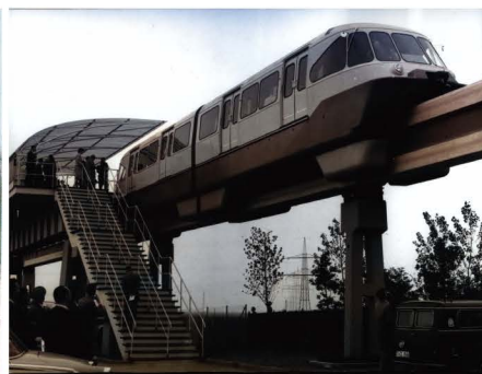
1951-1967 年 アルヴェーグ式モノレール イツ・フューリンゲン試験場の様子
